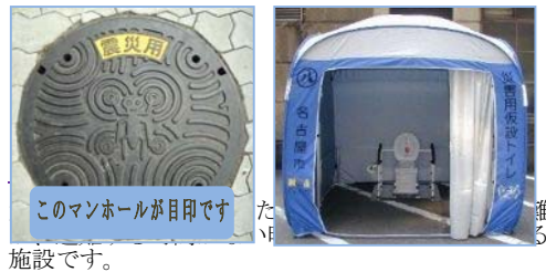
このマンホールが目印です。たいてい仮設トイレが設置されています。
