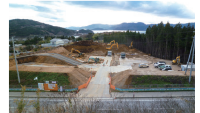
防災集団移転による高台の宅地整備
