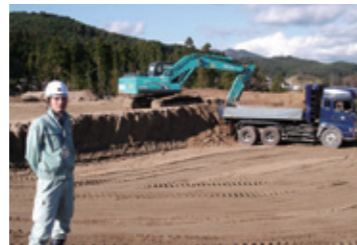
道路等復旧業務に従事する技師
