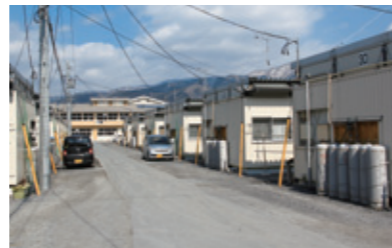
学校の校庭に建つ仮設住宅
